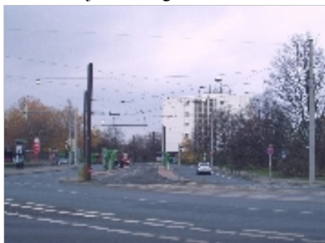
Limmer, Stadtteileingang Ost, Wunstorfer Straße Foto: gwer
